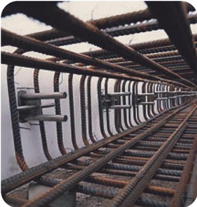
*La soluzione per il trasferimento degli sforzi di taglio in presenza dei giunti di dilatazione*
