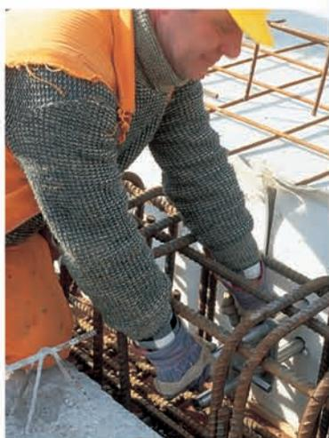
La soluzione per il trasferimento degli sforzi di taglio in presenza di giunti di dilatazione
